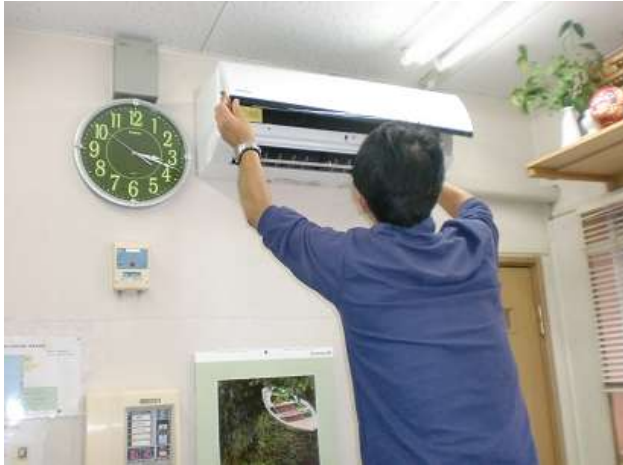
エアコンフィルターの清掃
